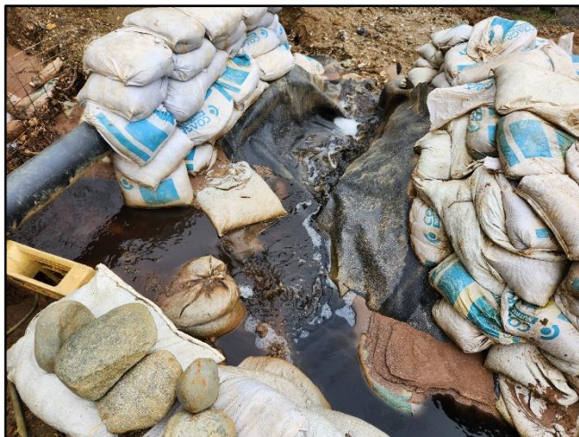
Fotografía 3. Fecha: 06.09.2024. Coordenadas UTM DATUM WGS84 18S Norte: 5.572.571. Este: 659.211. Descripción del medio de prueba: obra de aliviadero que se encuentra operativa y descargando lixiviados hacia la quebrada y que finalmente confluye al estero El Mosco.
