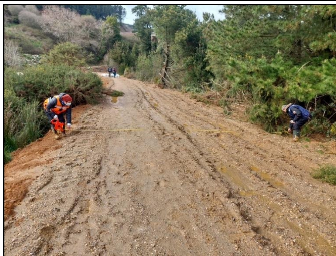
Fotografía 2. Fecha: 06.09.2024. Coordenadas UTM DATUM WGS84 18S Norte: 5.572.620. Este: 659.074. Descripción del medio de prueba: Peralte del talud sur (un metro de altura y entre 5,2 – 6,2 metros de ancho, aproximadamente) realizado con maicillo, para efectos de reforzar el talud sur de la laguna de lixiviados. Al fondo se aprecia acopio de sacos con material terreo, lo que han sido incorporados también ladera sur por el interior de la laguna.
